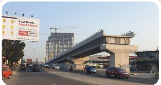
● PCU Girder Fly Over Rawa Panjang - Bekasi
