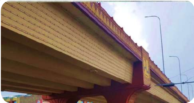
● PCU Girder Sudirman Pekanbaru Fly Over
