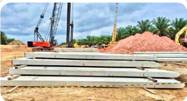
● Square Pile Toll Road Trans Sumatera Ruas Betung Simpang Sekayu Tempino Jambi 1A Section
