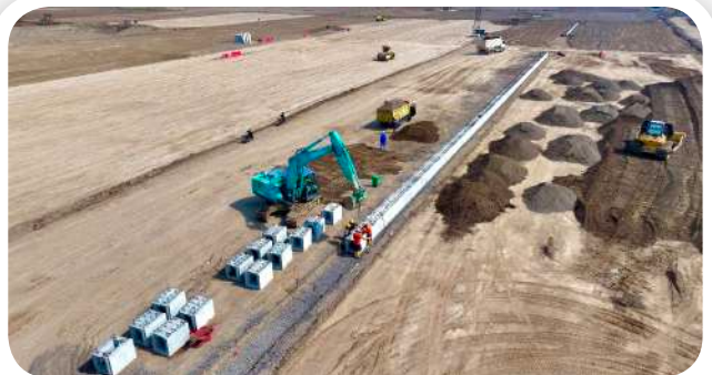
● Slit Ditch patimban Port Subang - West Java
