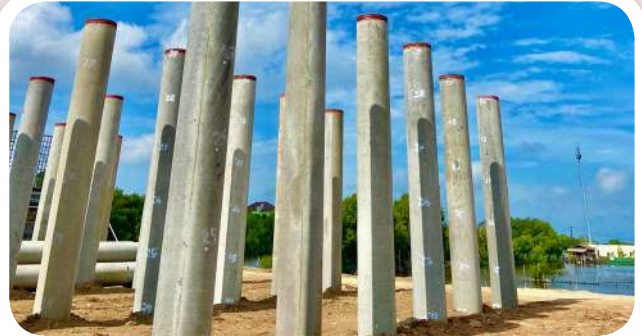
● Spun Pile Kartaraja (Kamal-Teluknaga-Rajeg) Toll Road
