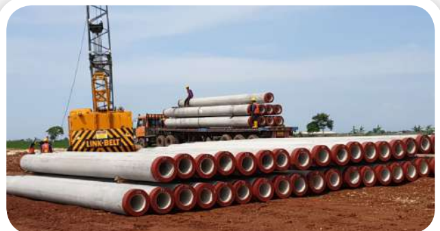
● Spun Pile Patimban Port Subang - West Java
