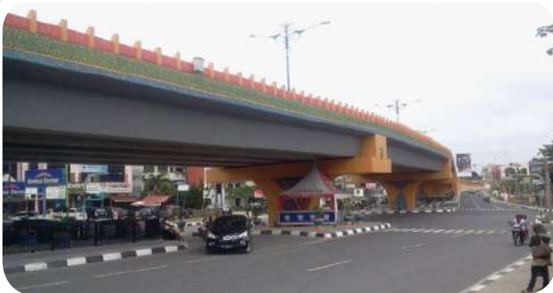
● PCU Girder Tanjung Siapi-api Fly Over
