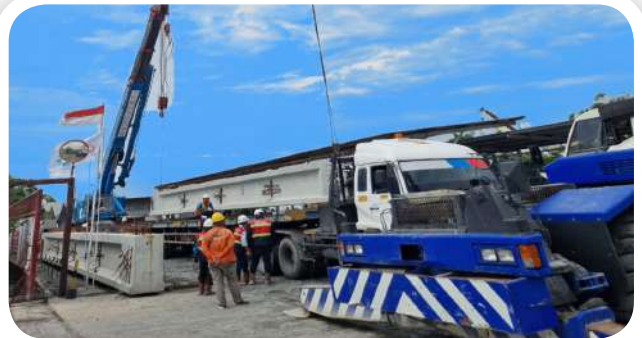
● PCI Girder LNG Sumbawa Luwuk - Central Sulawesi
